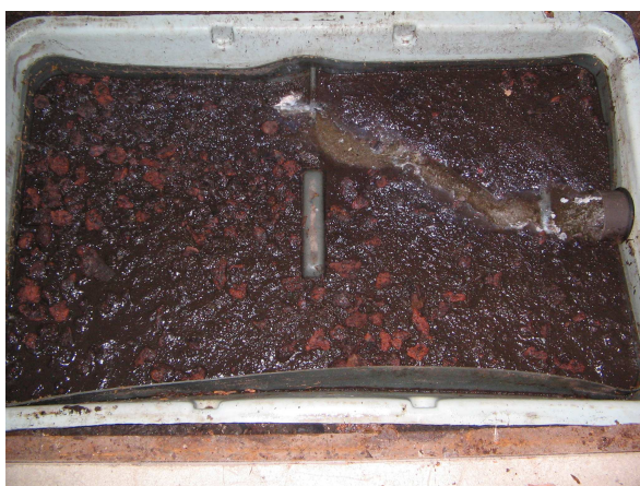
Mise en évidence d'un dysfonctionnement de la fosse
